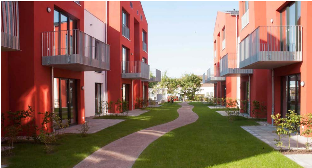
NEUBAU VON STADTHÄUSERN MIT TIEFGARAGE
